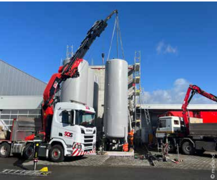
Aufstellen eines der fünf zusätzlichen Additivtanks.
